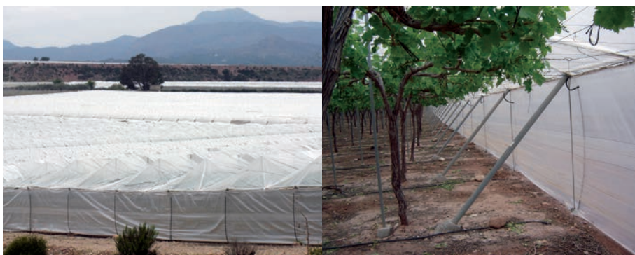
Estructura de malla típica para la producción de uva de mesa apirena en la Región de Murcia
